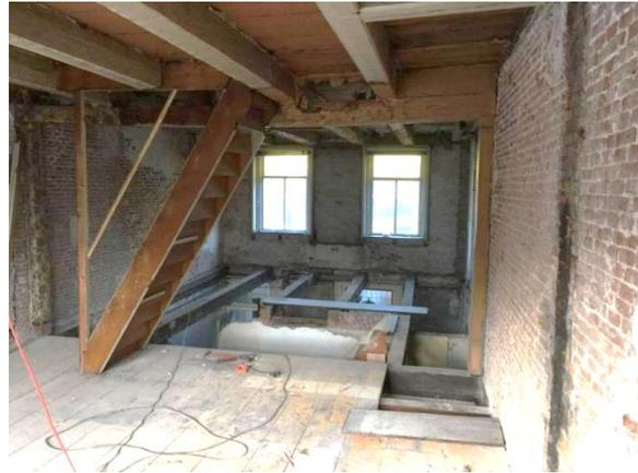
Abb. 23: Risiko bei Abbruch- und Rückbauarbeiten, bspw. durch Stolpern über Abbruchmaterial oder Abstürzen durch Bodenöffnungen (Piede, 2017; Kess, 2017)
