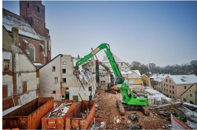
Abb. 22: Konventioneller Abbruch vs. kontrollierter Gebäuderückbau (Bayrisches Landesamt für Umwelt, 2019, S. 6; Wabner, 2021)
